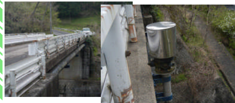
緊急No.1 山之上支線道路橋に添架する空気弁の取替補修（山之上地内）
