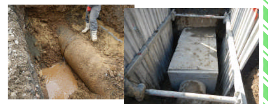
緊急No.4 八百津西分線PC管ジョイント部分の漏水補修工事（和知地内）
