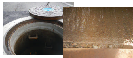
その他補修No.2 米田支線マンホール蓋のたつき補修（下米田地内）
