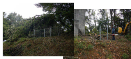
緊急No.3 羽生支線減圧水槽施設の倒木処理とフェンスの復旧工事（中蜂屋地内）
