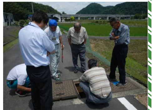
施工工事箇所の検査（中山分線漏水補修工事）
